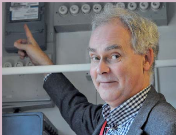
Martin Almgren i Västra Frölunda uppskattar möjligheten att kunna kontrollera elanvändningen timme för timme.
